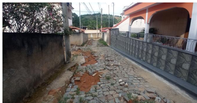
Fotos 3 e 4: Rua Antonio José Monteiro – Bairro Bonsucesso
